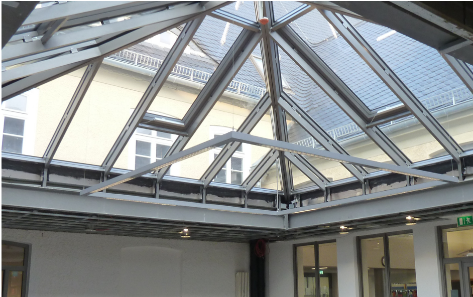
Die neue Glaskuppel steht symbolisch für den Umbau am Exer. Sie sorgt in der Ostfalia-Bibliothek für gute Lichtverhältnisse.
