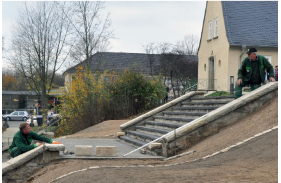
Hier verlegen Garten- und Landschaftsbauer neue Steine am Treppenaufgang.
