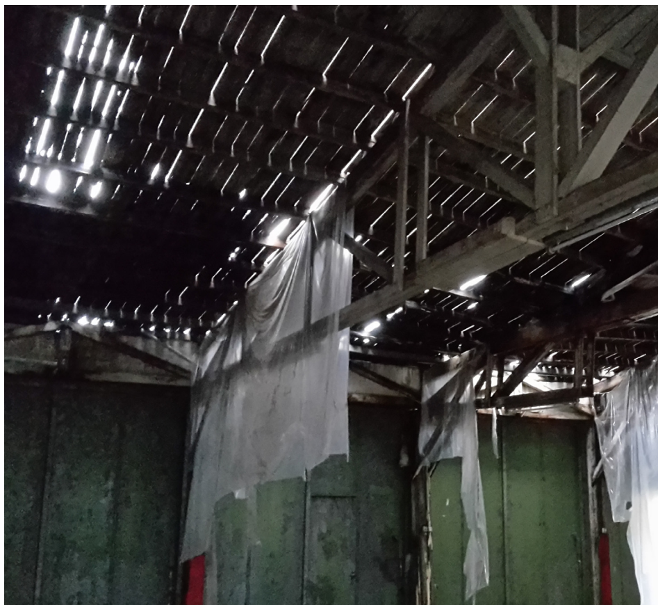
So sah es am Ende in der mittlerweile abgerissenen Halle 39 am Exer aus: Wasser trat ein.
