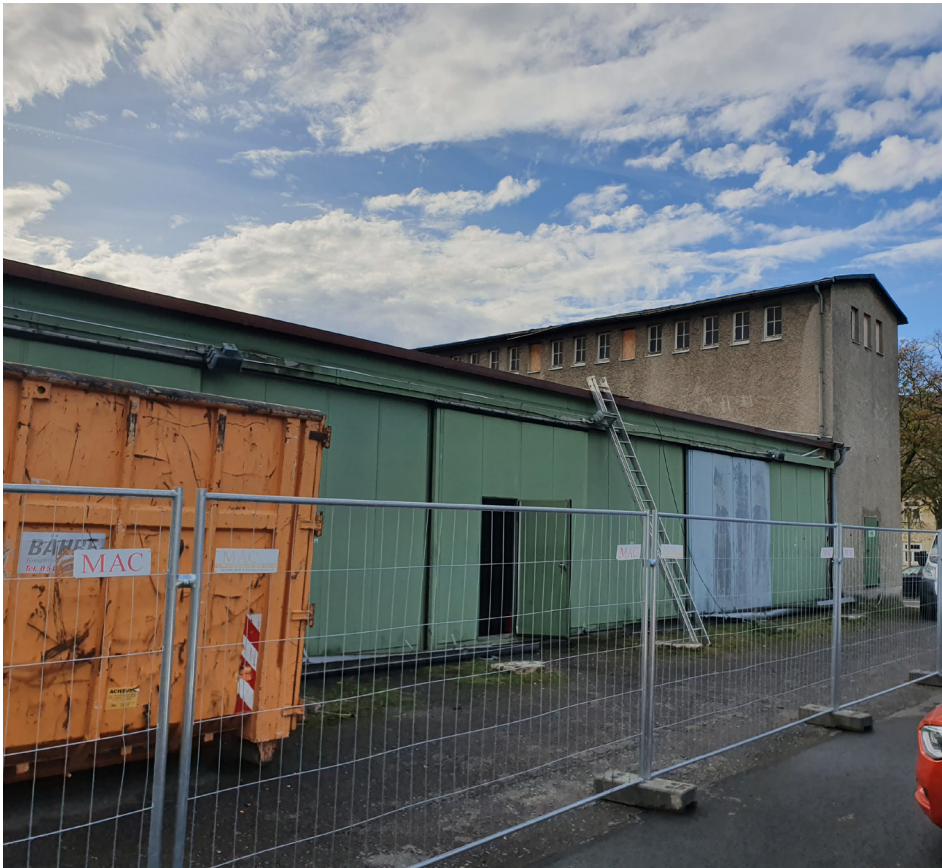
Die Halle AE41 war abgängig und wurde inzwischen abgerissen.
