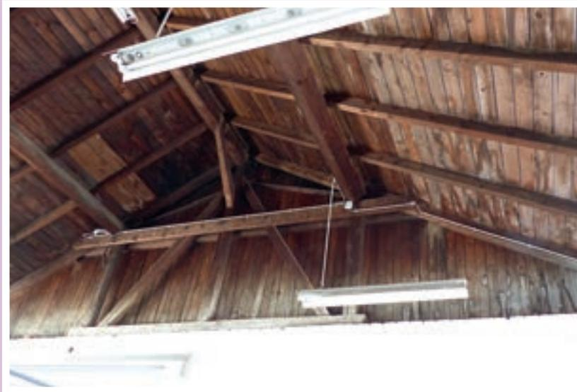
*Aufgrund der Holzdachkonstruktion in der noch unsanierten Halle AE 37 und damit sehr hohen Brandschutzanforderungen ist eine langfristige Nutzung als Lager vorgesehen.*
